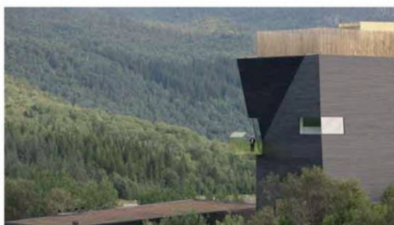
Hamsunsenteret på Hamarøy vant byggeskikkprisen 2011 (Foto: Iwan Baan).
